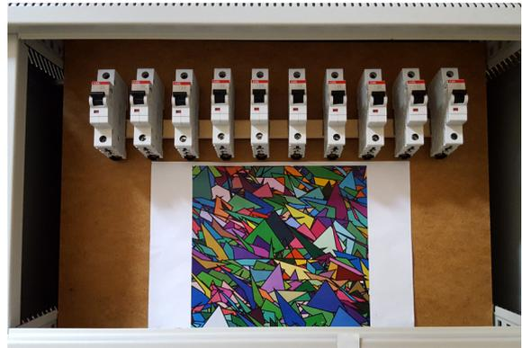
**Abb. 3-7** Musterbasierter Marker in einem Schaltschrank
