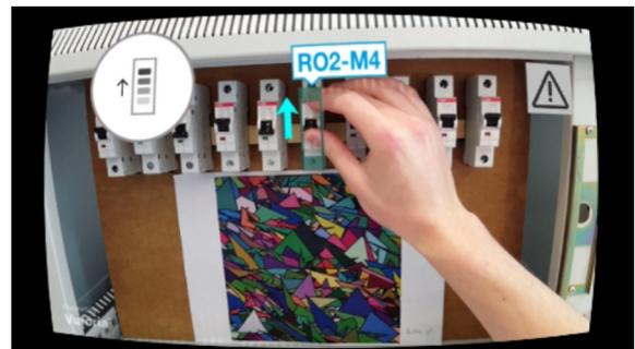
**Abb. 7-12** Schritt 3: Schutzschalter zurücksetzen
